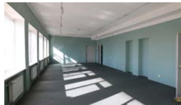
Ēkā A. Paulāna ielā 1A, šobrīd noris remontdarbi
