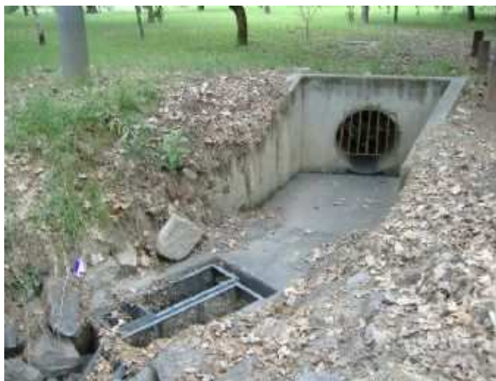
Рисунок 9. Адаптированные для ливневой воды капканы позволяют не допустить попадание неочищенных дождевых вод в реки
