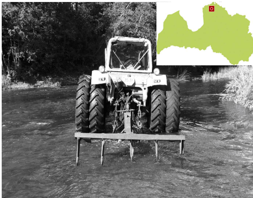
Рисунок 5. Процесс рыхления русла и полки корневой системы водных растений в реке Салаца
