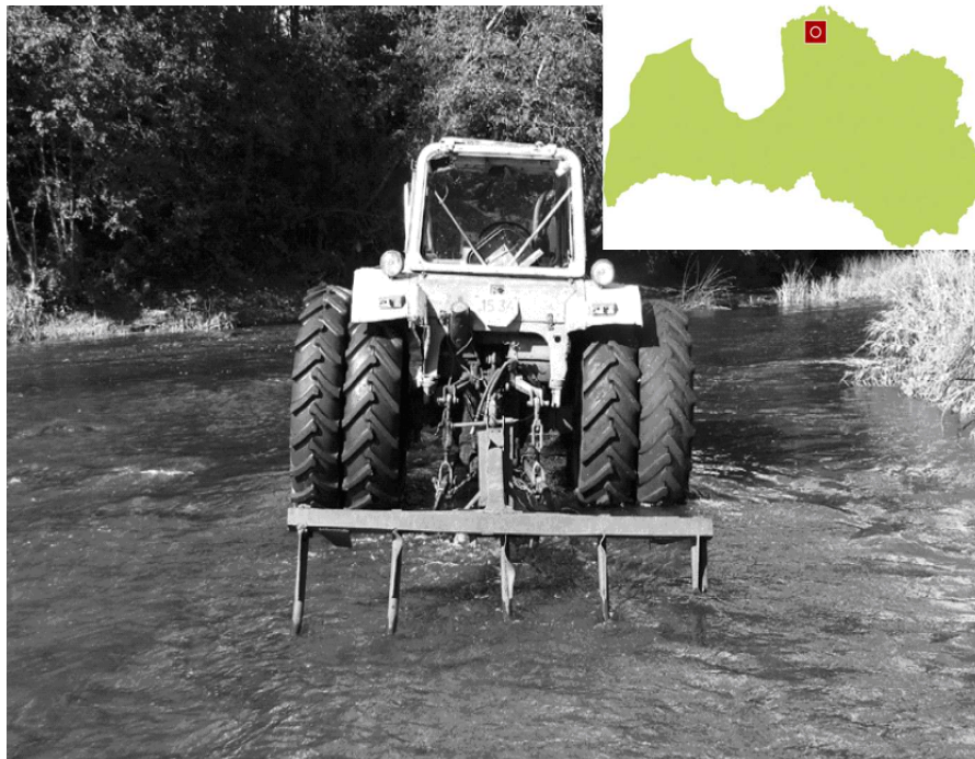
5.attēls. Gultnes irdināšanas un ūdensaugu sakņu sistēmas ravēšanas darbi Salacas upē
